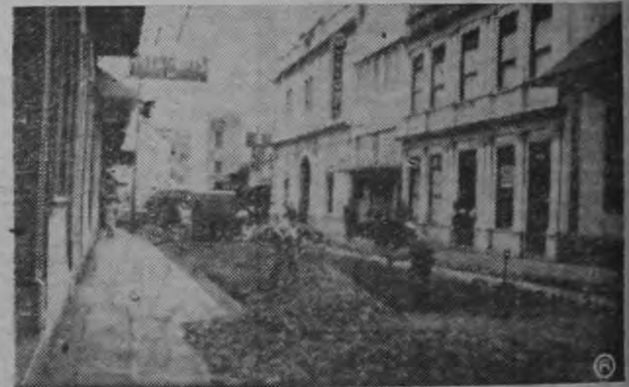
Rápidamente se están realizando los trabajos de pavimentación en la Avenida Tercera, entre el Correo Central y la Imprenta Nacional. El armazón de hierro de la nueva pista asegura su duración. (Foto Orlando COTO).
